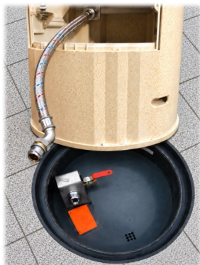
Installation de la Borne OHSA pour distribution hydraulique
