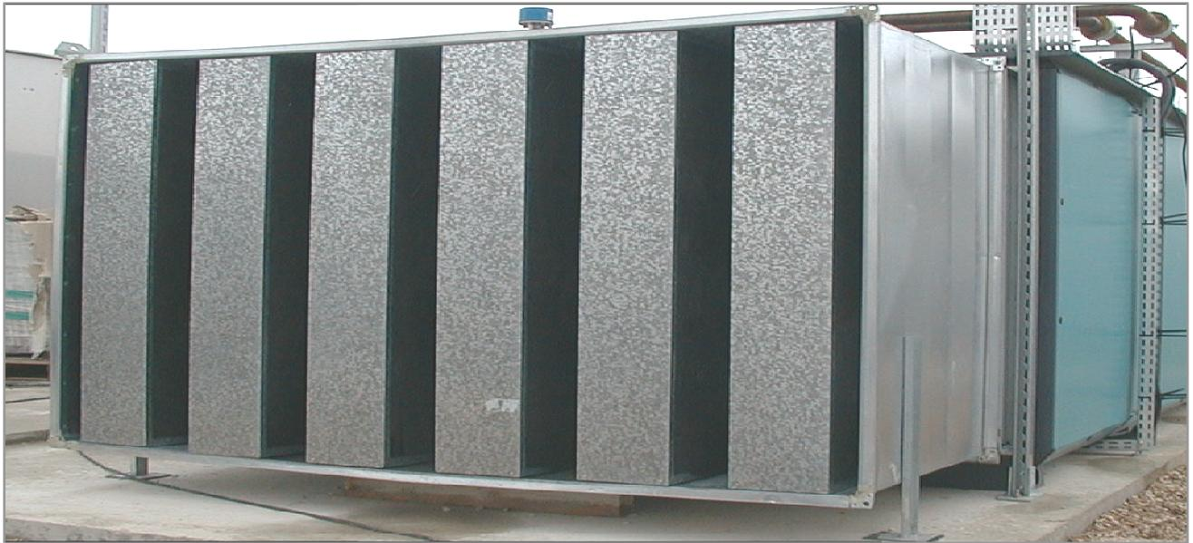
**NOTA :** le montage des baffles s'effectue en laissant une ½ voie d'air aux 2 extrémités du caisson.
