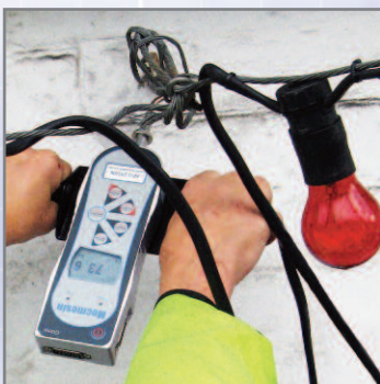
Essai de traction sur points d'ancrage
