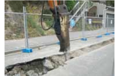
Tranchées, terrassement et VRD
