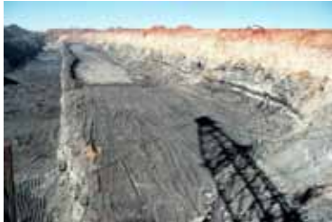
Abattage, nivellement de talus, de routes et de rampes
