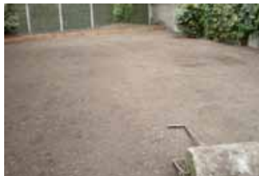
Nivellement du sol
