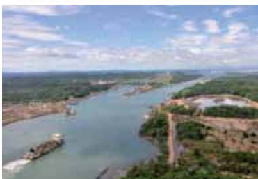
Approfondissement et extension de docks
