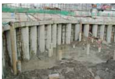
Fonçage de pieux de fondation
