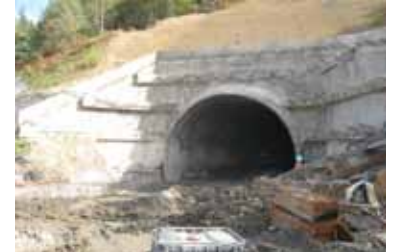
Percement de tunnels, reprise de voûte, de face et de bordure d'exploitation, nivellement de sols
