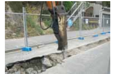
Tranchées, terrassement et VRD
