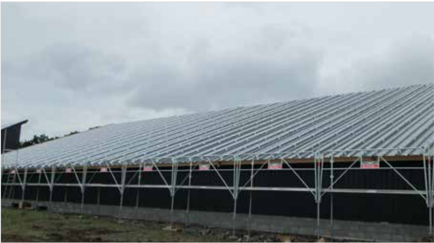
Saint Léger sur Sarthe | Société Solesens Installation 100 Kwc | Système KoverRail
