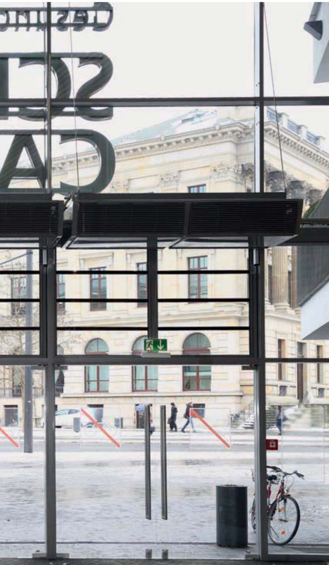
Schlosscarree, Braunschweig: un confort extrême pour les visiteurs au niveau des différentes entrées grâce au rideau d'air Tandem 385.
