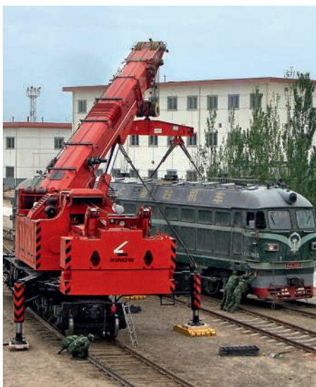
↑ Interventions après accident
