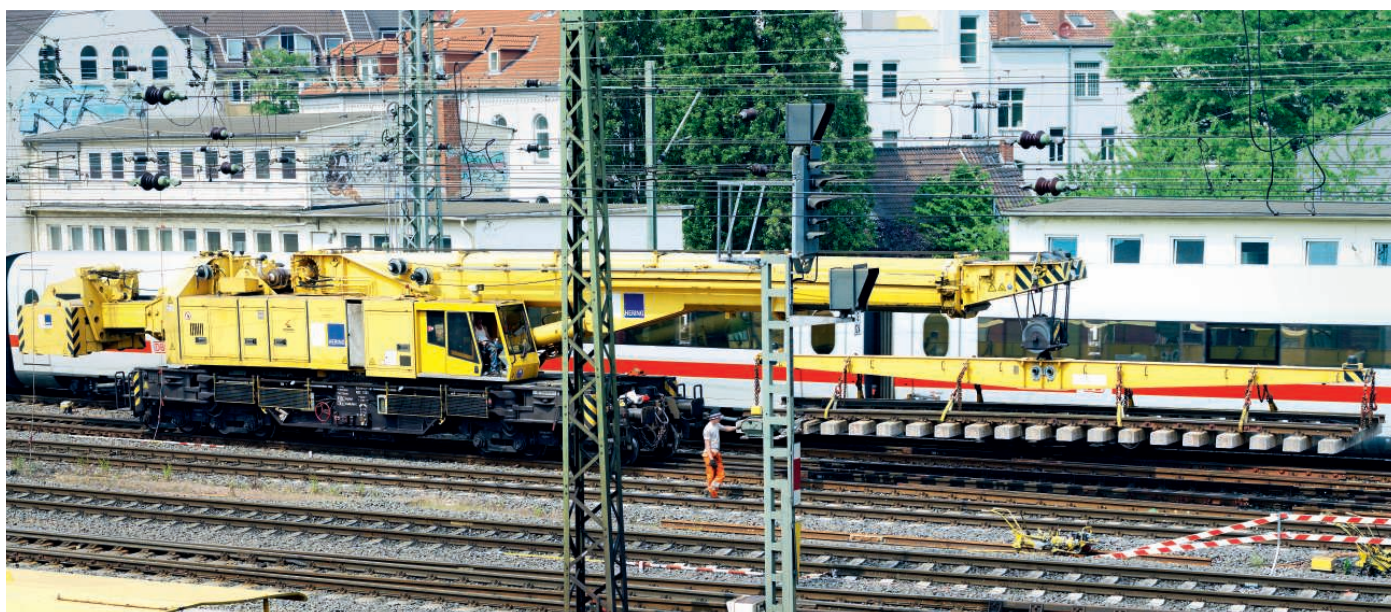
↑ Construire et rouler. Le Multi Tasker ne gêne pas la circulation des trains
