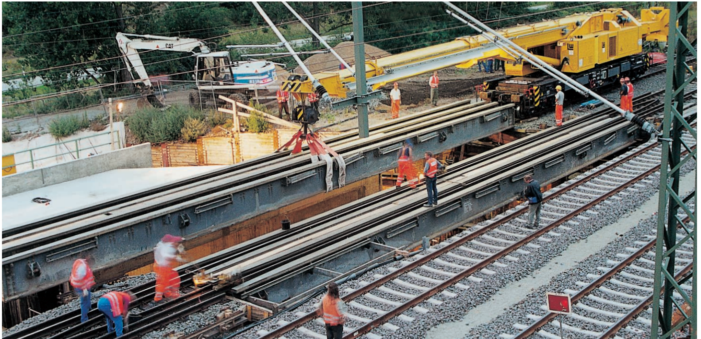
↑ Multi Tasker 1200 lors du levage du plus grand pont provisoire de la DB AG
