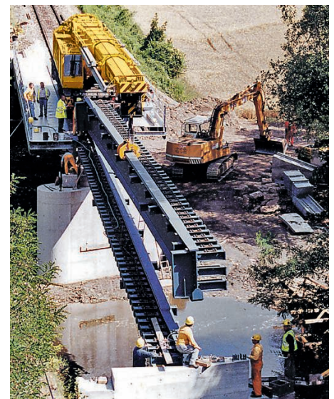
↑ Efficacité lors de la pose d'une poutre de pont
