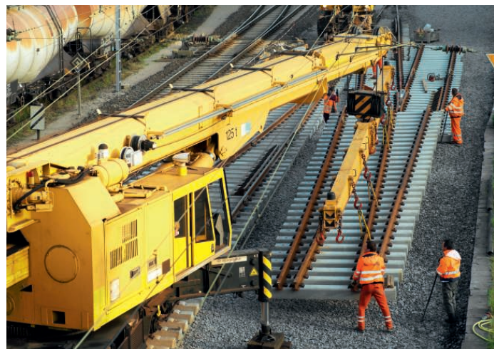
↑ Portions d'aiguillage posées latéralement
