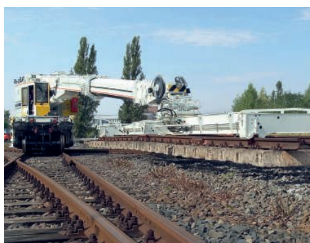
↑ Les tronçons de voie peuvent être déplacés à l'aide de palonniers hydrauliques
