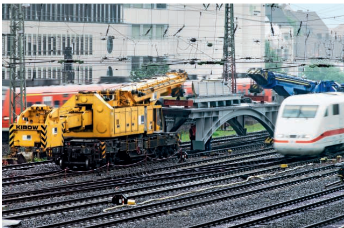
↑ Construction de pont en mode tandem
