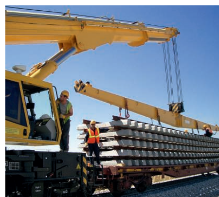
↑ Les tronçons de voie sont directement posés du wagon sur la portion de tracé voisine
