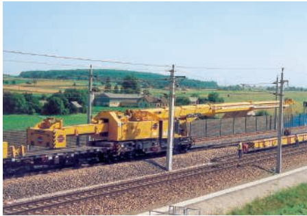
↑ Pose de tronçons de voie dans un espace restreint
