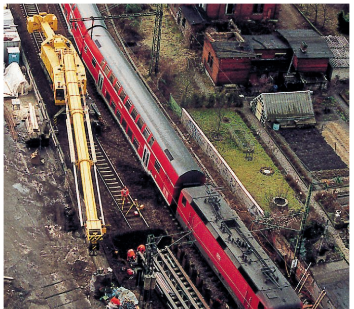
↑ L'agencement particulier des contrepoids sur le Multi Tasker permet de réaliser des travaux sans obstacle avec seulement une bécquille.
