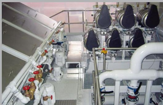
Disc-O-Filter® pour la filtration absolue sur une installation
