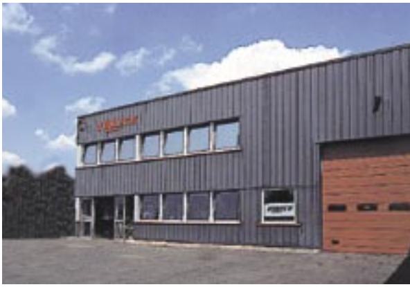
Bureaux et magasins à Villepinte.
