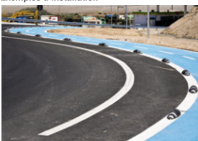
Parallèlement à l'axe de la route
