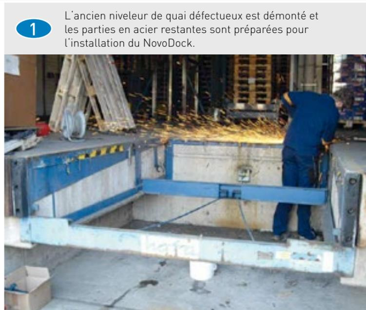
**1** L'ancien niveleur de quai défectueux est démonté et les parties en acier restantes sont préparées pour l'installation du NovoDock.
