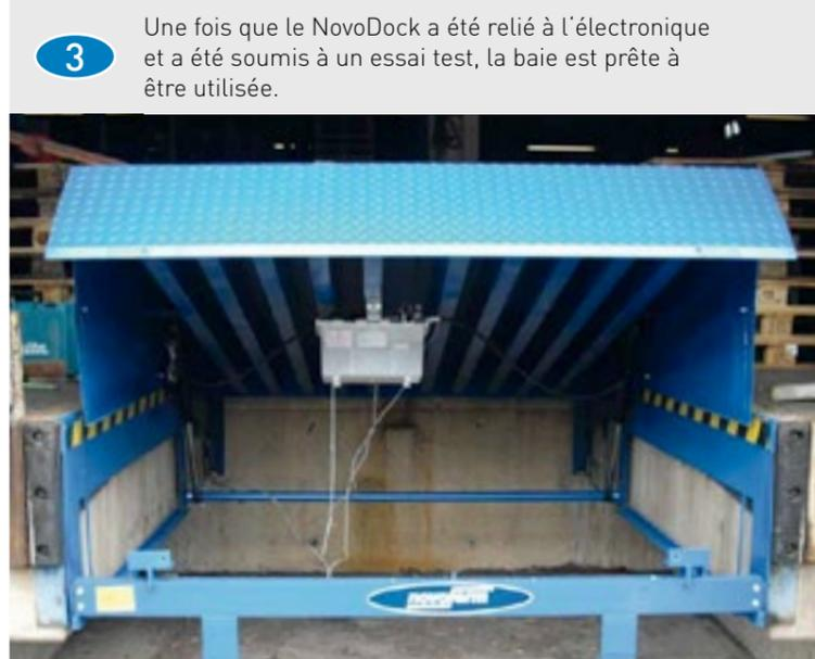
**3** Une fois que le NovoDock a été relié à l'électronique et a été soumis à un essai test, la baie est prête à être utilisée.
