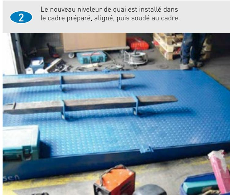
**2** Le nouveau niveleur de quai est installé dans le cadre préparé, aligné, puis soudé au cadre.
