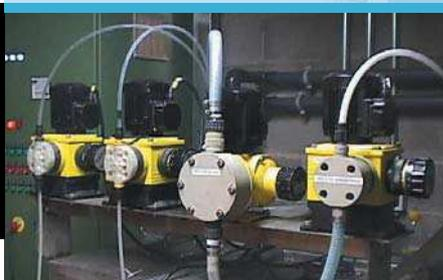
**Injection de coagulant, de floculant et de soude dans un process de traitement des eaux après application de cire liquide**
