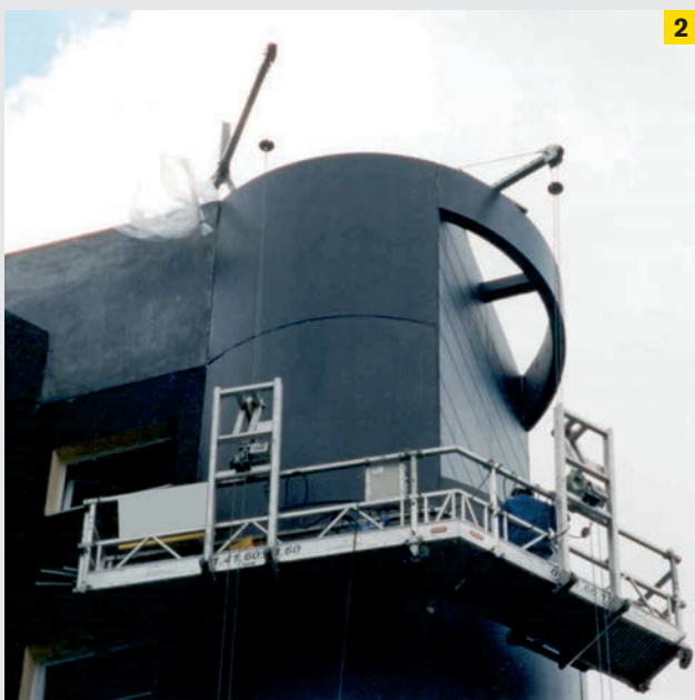
1 Plate-forme à 2 niveaux pour travaux de bardage. 2 Plate-forme d'angle.
