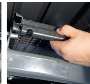
Démontage des grilles
