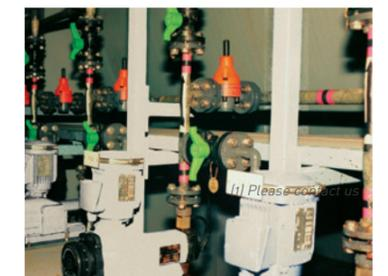
Pompage de chlorure ferrique en station d'épuration.
