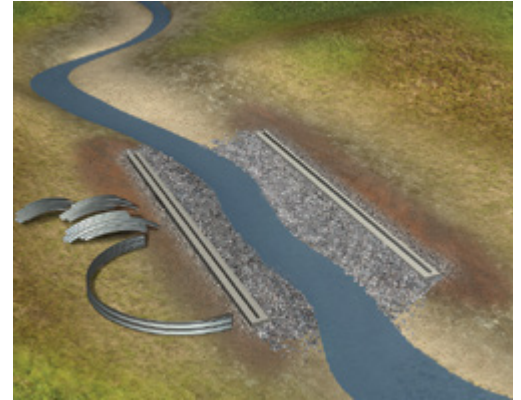
Le premier segment d'arche est entièrement assemblé au sol.
