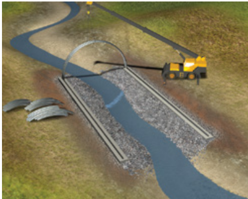
Il est ensuite levé pour être mis en place et boulonné aux semelles de chaque côté.
