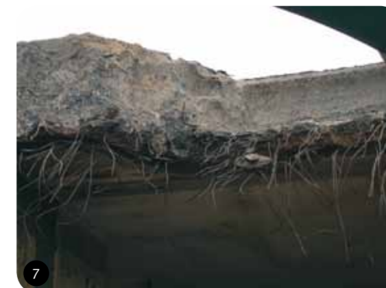
4 + 5 Suède Une ERW 600 , avec une roue de fraisage spéciale pour le béton armé, creuse des fentes de 60 cm de profondeur à une vitesse de 12 m/h.
