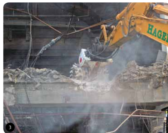
3 Allemagne Une ER 3000 utilisée sur un projet de démolition en Allemagne.
