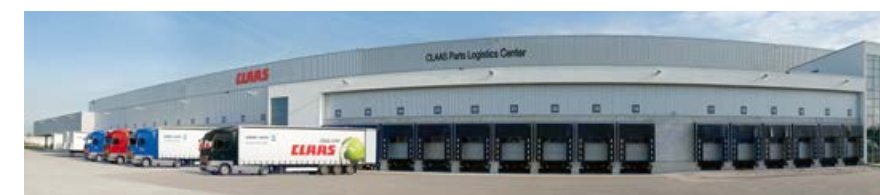
Situé à Hamm, en Allemagne, le centre logistique PDR CLAAS abrite 155 000 références sur une surface de plus de 100 000 m 2 .
