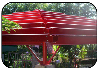
Protection des charpentes
