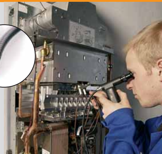
Inspection visuelle lors de la maintenance d'une chaudière
