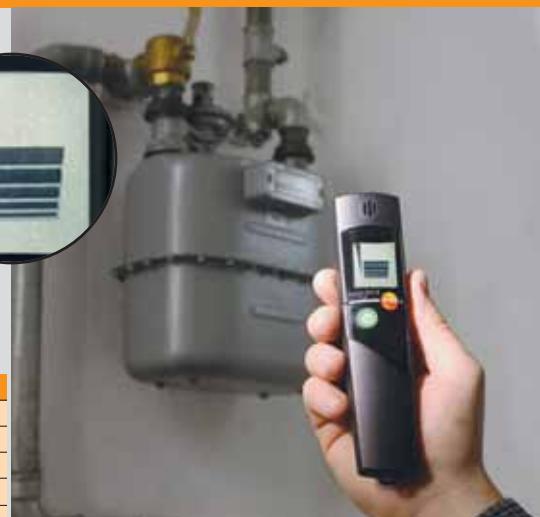
Indication sonore de fuites de gaz sur des soudures, coudes....
