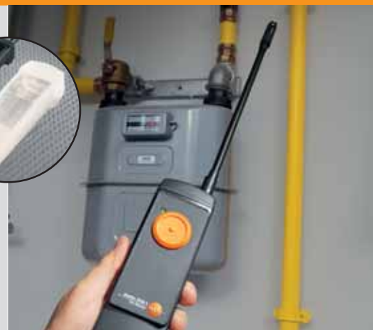
Contrôle d'étanchéité sur des conduites de gaz d'installations domestiques
