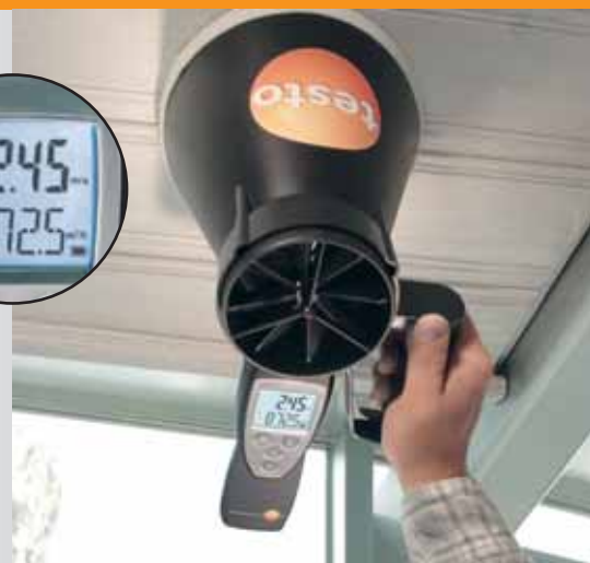
Contrôle du débit d'une V.M.C.
