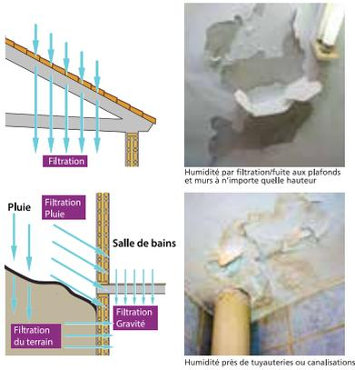
Humidité par filtration/fuite aux plafonds et murs à n'importe quelle hauteur
