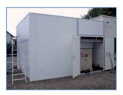
Réalisations de cloisons, d'écrans et de capotages acoustiques avec des panneaux EKOMODULE.
