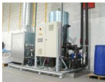
Application refroidissement salle climatique (plage de température -20°C à +20°C)
