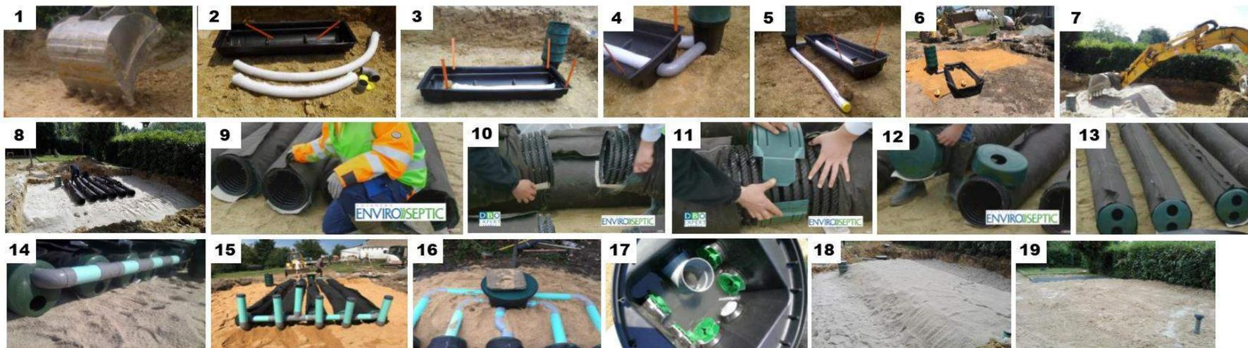
1- Terrasser la surface d'infiltration. Scarifier le fond de la fouille.
