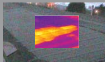
Image mixte, obtenue par la fonction Fusion, révélant l'eau infiltrée dans le mur et la moisissure.
