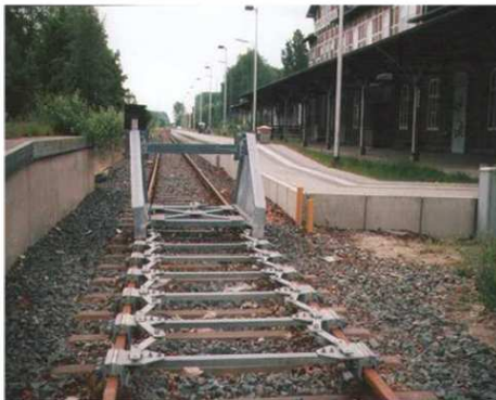
Heurtoir de freinage avec des éléments de freinage supplémentaires
