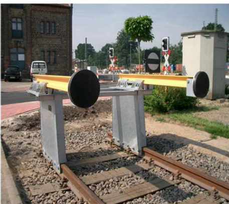
Heurtoir fixe avec un dispositif de tampon de freinage
