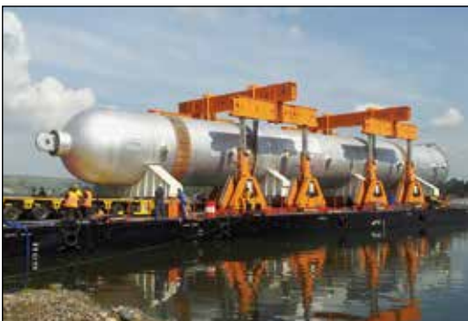
◀ Deux portiques SBL1100 ont permis de soulever cet hydrocraqueur de 1300 tonnes au-dessus de la barge pour le déposer sur un transporteur modulaire automoteur SPMT.
