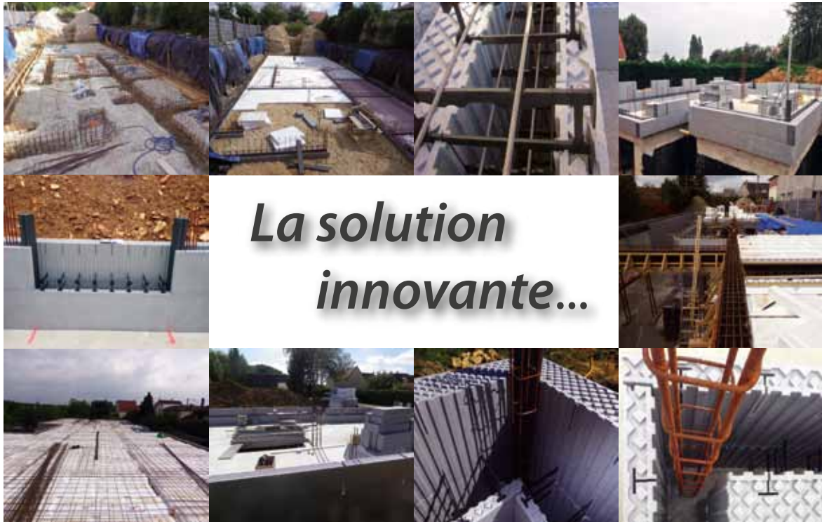
Exemples de chantiers réalisés en blocs coffrants isolants.
