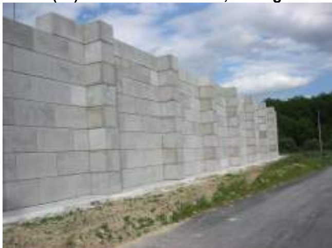
Reims (51) Hauteur des murs 6,4m largeur 16m profondeur 50m
