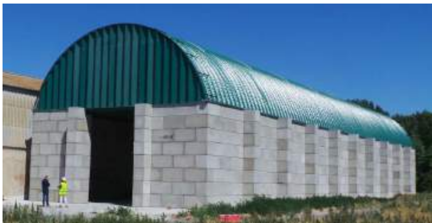
Reims (51) Hauteur des murs 6,4m largeur 16m profondeur 50m
