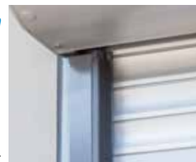
Tablier du volet avec remplissage en mousse rigide
