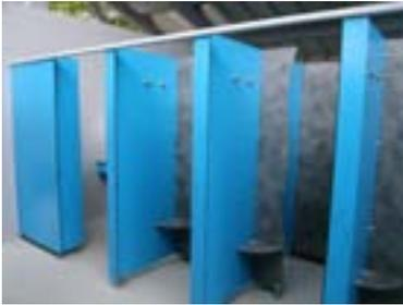
Réalisation de cabines sanitaires en panneaux stratifié compact ép.10mm pour la réalisation de cabines douche, WC, lavabo, déshabillage...
