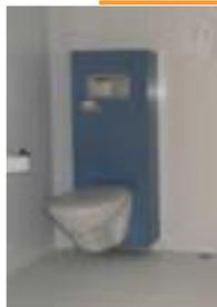
Coffre pour bati support, avec ou sans trappe démontable en panneau compact ép.10mm
