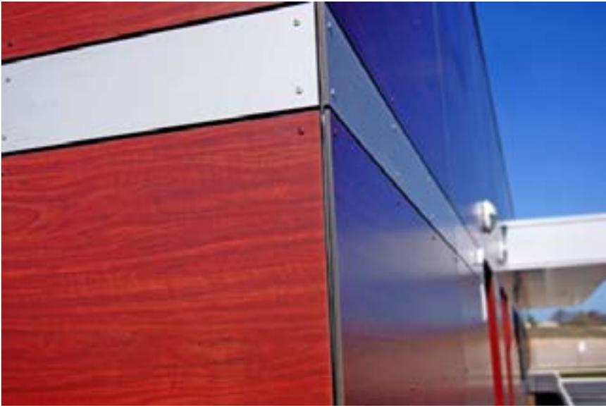
Bardage extérieur pour isolation thermique en façade ventilée. Durable, le Polyrey Façades, constitué de panneaux stratifiés hydrofuges et imputrescibles, résiste au rayonnement UV, aux intempéries, aux chocs climatiques. ... et offre une excellente conservation des couleurs dans le temps. Il se monte sur ossature bois ou alu, aussi bien en neuf qu'en rénovation.
