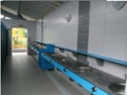
Réalisation de plans sur mesure en panneaux stratifiés compact ép.10mm.
