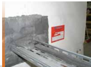
La mousse EasyPART' : le compartimentage coupe-feu agréé pour passages de câbles.
