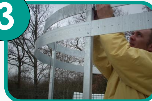
LA STRUCTURE DU SANITAIRE EST ASSEMBLEE ET POSITIONNEE
