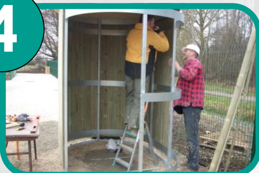
LES PAROIS SONT FIXEES
