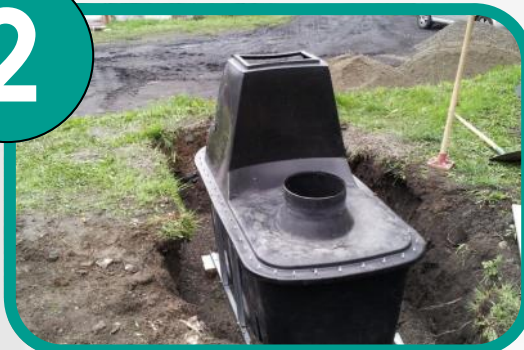
LA CUVE EST MISE EN PLACE
