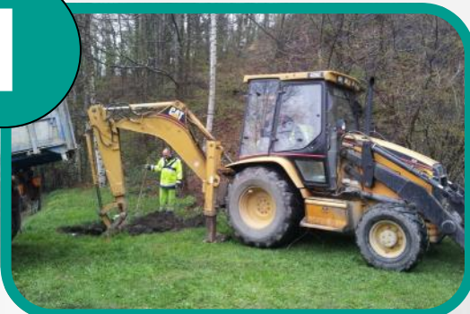
TERRASSEMENT POUR INSTALLER LA CUVE
