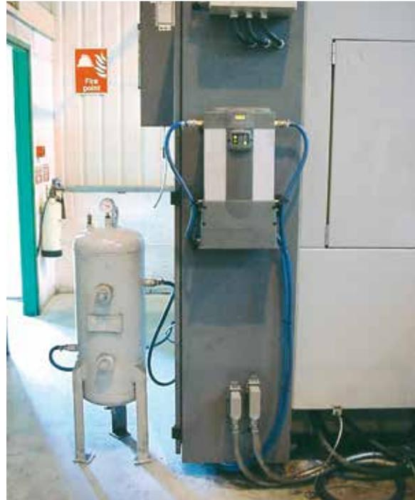
Un mini-sécheur d'air installé pour approvisionner des machines-outils numériques en air de commande.
