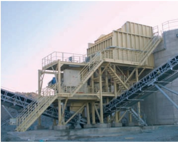
Un C125 pendant la phase d'installation dans une nouvelle unité de concassage primaire.
