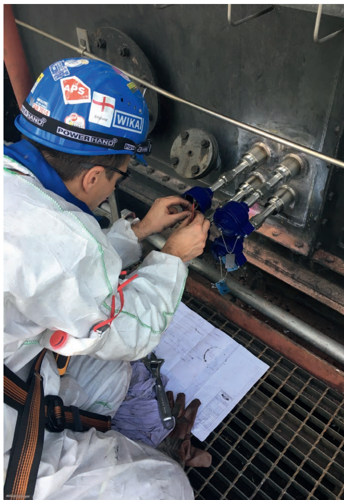
Transmission de signal et test de fonctionnement
