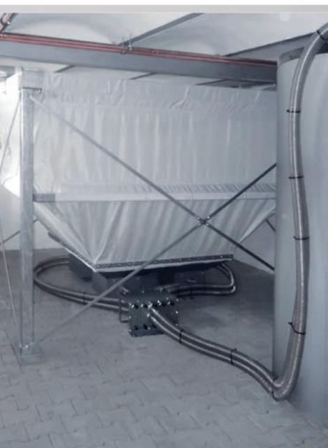
Flexilo MODUL avec 4 prélèvements dans une chaufferie
