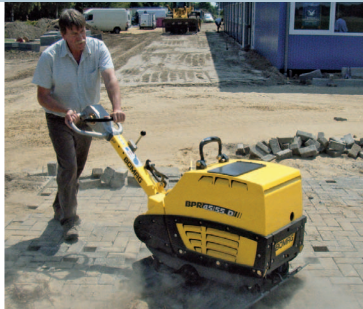
Particulièrement bien adaptées aux travaux de pavage grâce à la semelle en plastique (en option).
