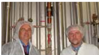
Vulcan installé dans une usine de production alimentaire
