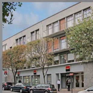
Logements collectifs + locaux commerciaux/rénovations : radiateurs, version 100% sans fil, gestion centralisée pr l'exploitant
