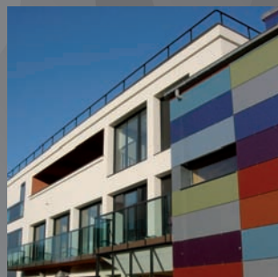
Tertiaire neuf : panneaux rayonnants et radiateurs, mixte, Centre social (95)
