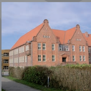
Tertiaire rénovation et extension : plinthes chauffantes + de 100 pièces gérées par PCI-profile
