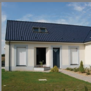
Résidentiel neuf : plancher chauffant et radiateurs avec panneaux solaires (Gitec - Anzin)
