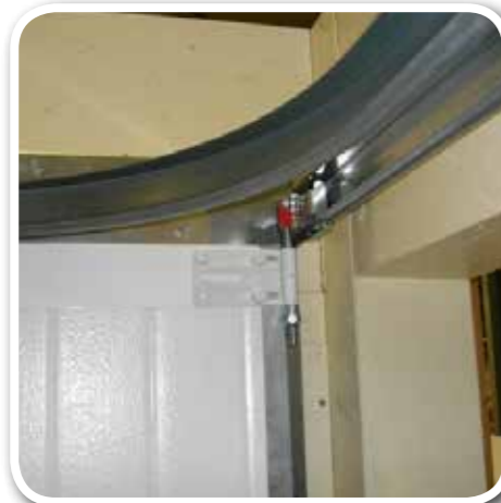
Double rail pour écoinçon réduit (110 mm)
