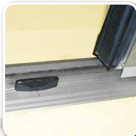
Seuil aluminium avec joint brosse
