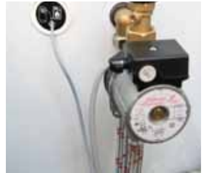
Pour le raccordement à la chaudière, installation des kits hydraulique et sonde sanitaire
