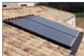
Capteurs intégrés au toit Tuiles
