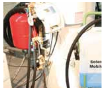
Etape de remplissage en fluide caloporteur
