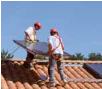
Positionnement des premiers capteurs
