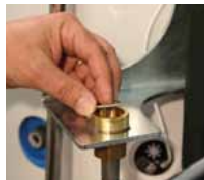
Placement du joint sur le raccord du vase d'expansion
