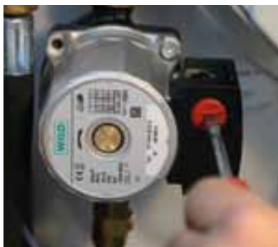
Réglage de la vitesse du circulateur
