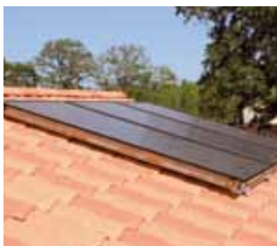
Capteurs posés sur tuiles
