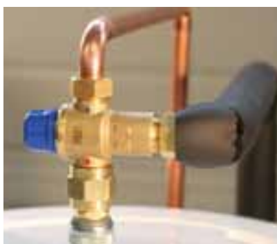
Raccordement eau chaude et montage du mitigeur thermostatique
