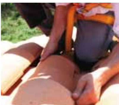
Recouvrement avec les tuiles
