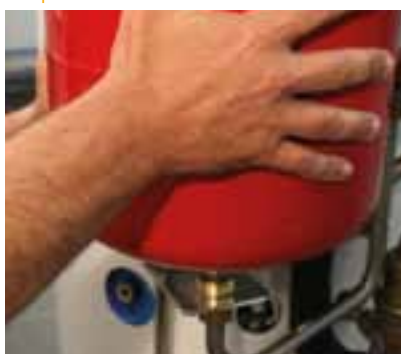
Montage du vase d'expansion sur la station solaire
