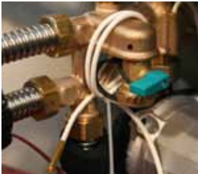
Dans le cas d'un hydrosolaire, récupérer la sonde sanitaire fixée sur la station
