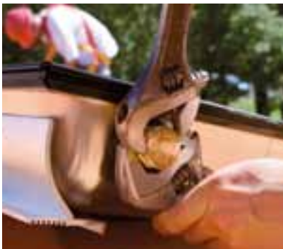
Mise en place des bouchons
