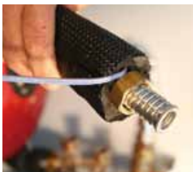
Collet battu sur twintube pour raccordement sur la station solaire
