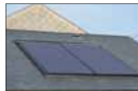
Capteurs intégrés au toit Ardoise
