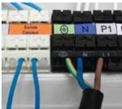
Raccordement électrique (sonde capteurs, contact HC, alimentation)
