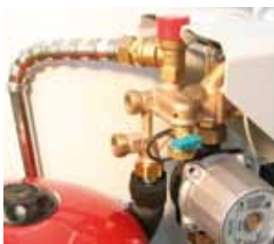
Raccords aller/retour du circuit solaire sur la station solaire
