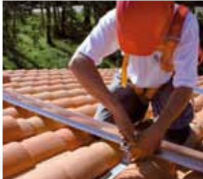
Montage des rails
