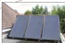
Capteurs sur châssis Toit plat ou terrasse
