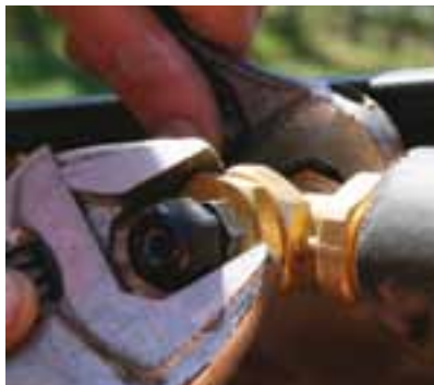
Raccordement de la sortie
