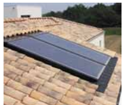
Capteurs intégrés aux tuiles
