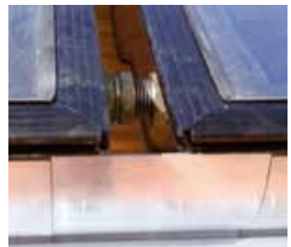
Vissage des compensateurs
