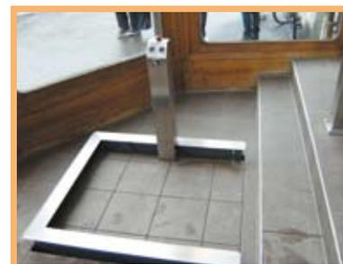
Avant l'élévation de plate-forme, des plinthes sortent du sol afin de bloquer le fauteuil et éviter sa chute
