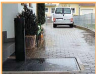
La plate-forme permet en position basse (contact au sol) le passage d'une voiture particulière
