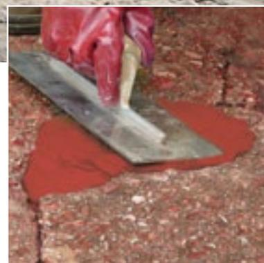
Watco Mortier Coulable est un produit prêt à gâcher pour reboucher les trous et les fissures sur les sols en béton, à l'intérieur comme à l'extérieur. Il donne une réparation très solide qui peut supporter une circulation piétonnière après 30 minutes ou de chariots élévateurs après 2 heures environ.
