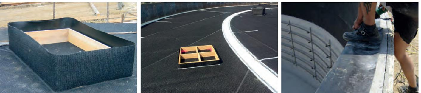
Die AGROTEL Betonschutzfolie WireTarp besteht aus einem Schlingengewebe und ist mit Polypropylen beschichtet. Diese wird im entsprechenden Bereich einfach und schnell verlegt und verschweißt. WireTarp ist eine Gesamtlösung, die optimal auf den Verwendungszweck Betonschutz abgestimmt ist!
