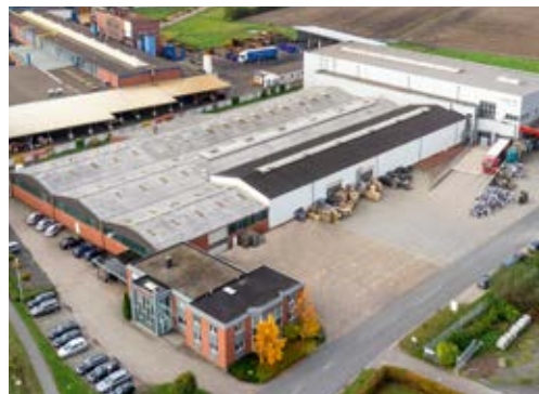
Site de production de Dinklage (Allemagne)
