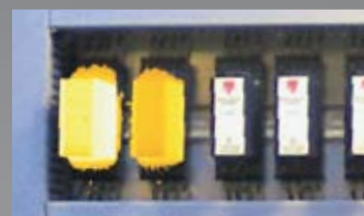
Image mixte, obtenue par la fonction Fusion, d'une surchauffe de coupe-circuit
