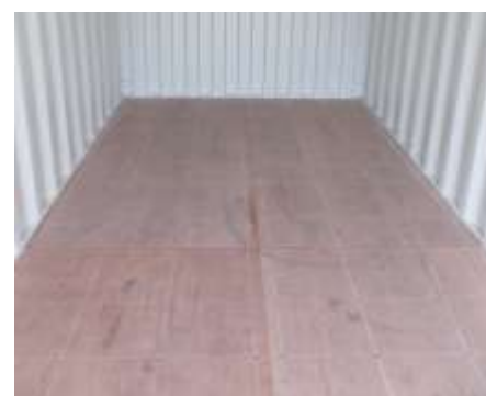
Plancher bois d'origine
