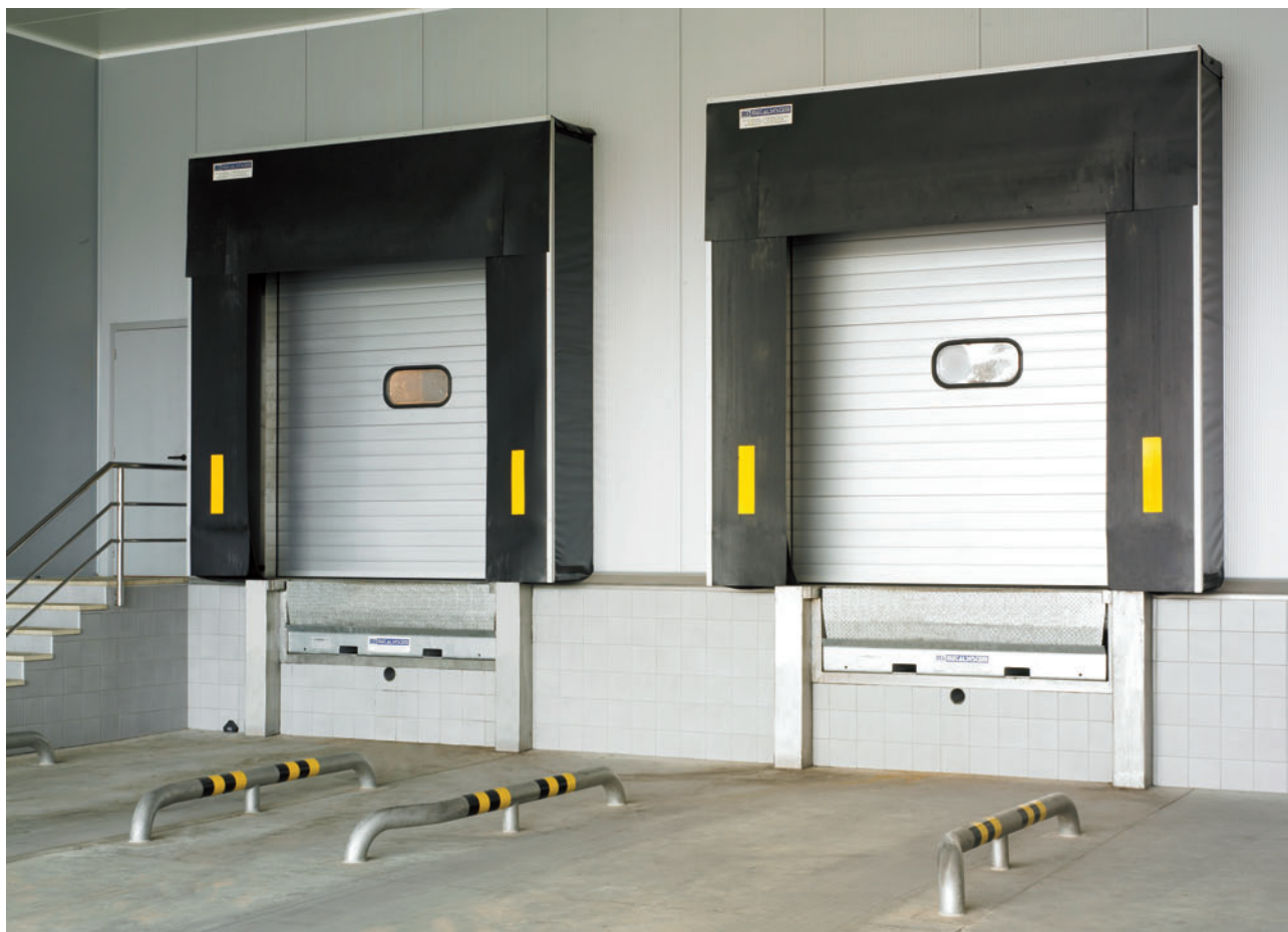
Quai de charge avec SAS flexible
