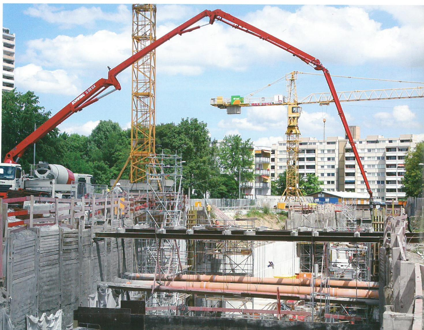
Comparé à d'autres concepts de structures avec stabilisateurs, celui-ci apporte une tranquillité de fonctionnement absolue de l'installation de pompage en particulier sur la partie arrière de la machine.
